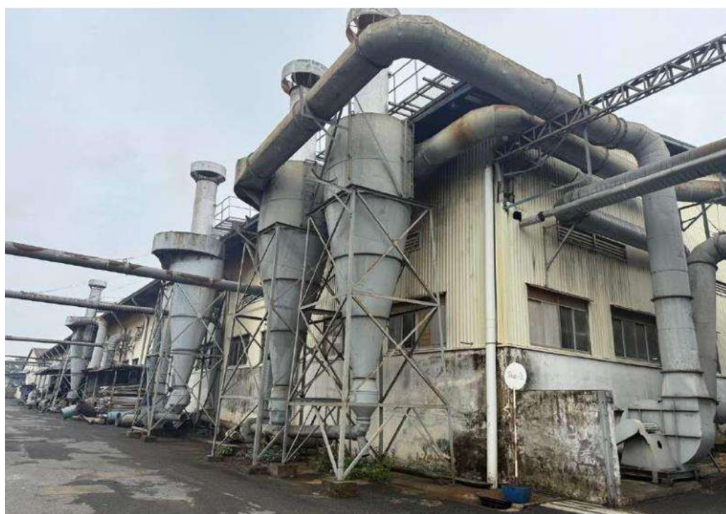
Hình 3.7. Hình ảnh hệ thống xử lý bụi từ công đoạn cắt gọt, gia công chi tiết
